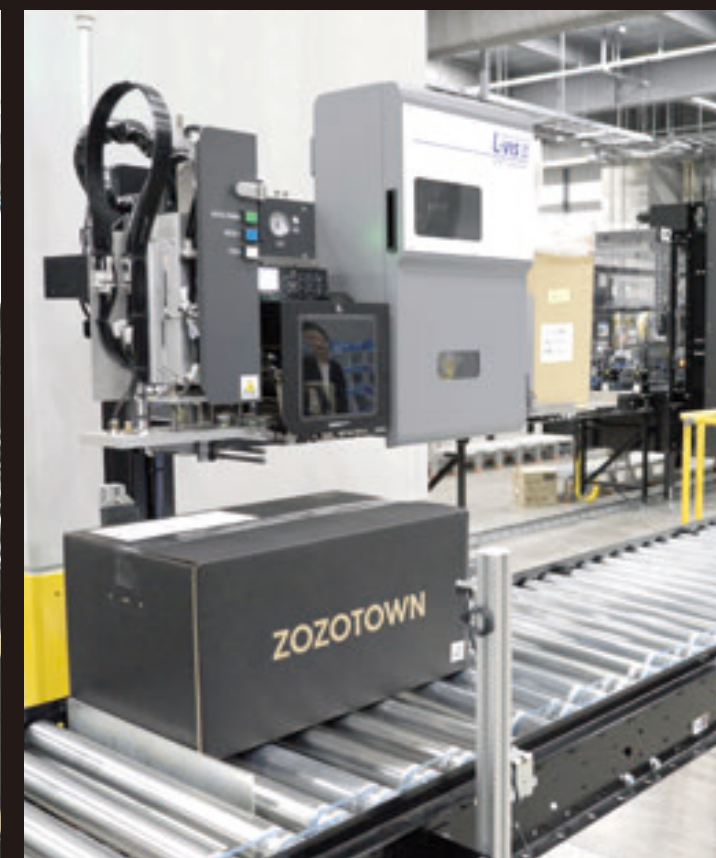
⑤梱包・出荷エリア 箱詰め後は、コンベヤに投入され、ランダム封函機で自動封函されます。その後、オートラベラにより、自動で荷札が貼られ商品が出荷場に搬送されます。
