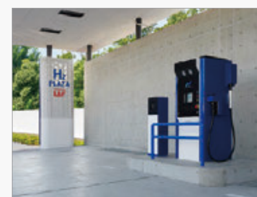
H 2 PLAZA 水素充填設備
