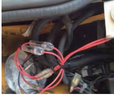
フォークリフトバッテリー との接続
